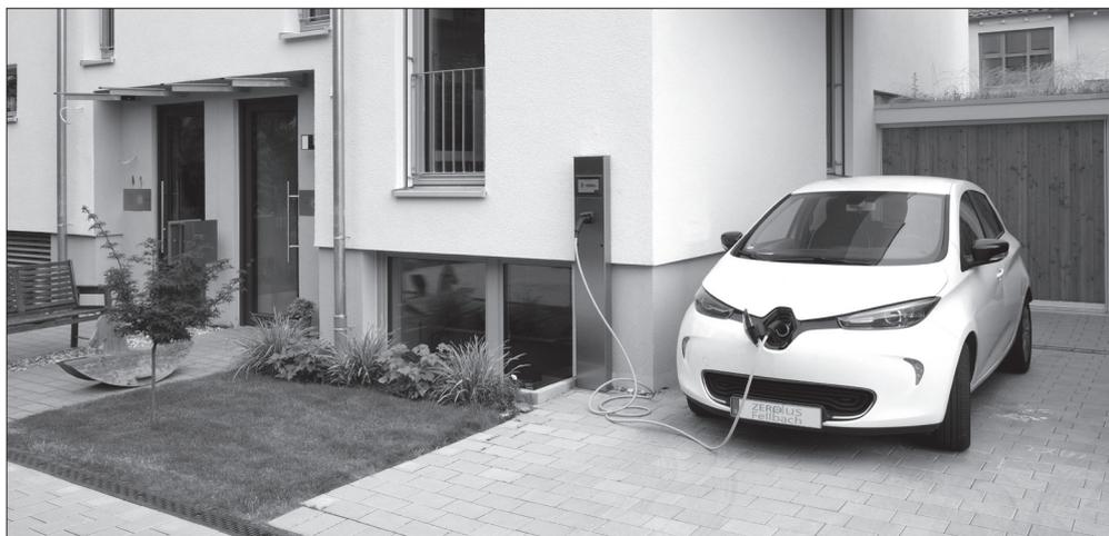
**Über eine Ladestation wird das Elektrofahrzeug mit PV-Strom vom Hausdach versorgt.**
